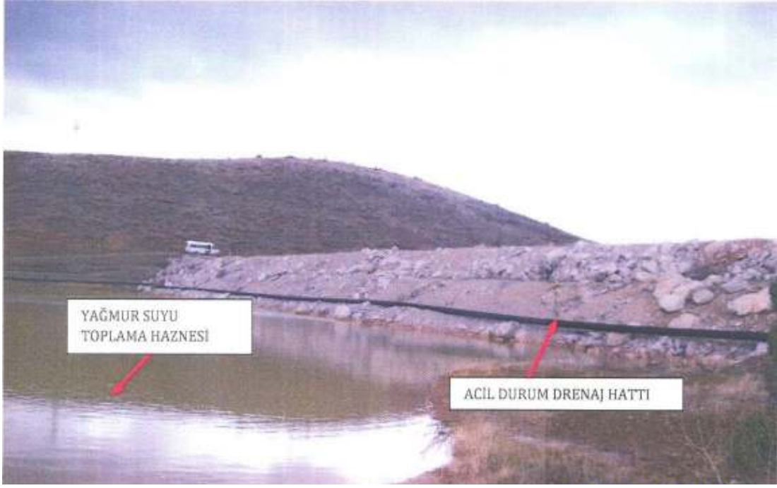
Şekil 4. Yağmur Suyu Haznesi Ve Acil Durum Hattı
